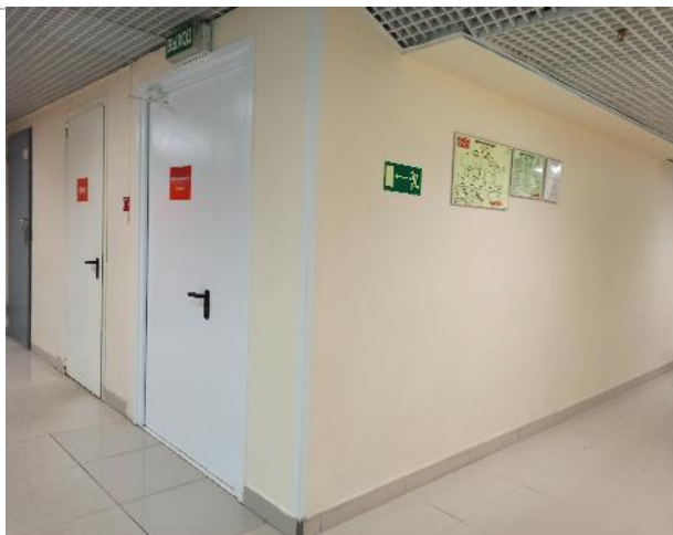
Фото 89. Внутренние помещения цокольного этажа.
