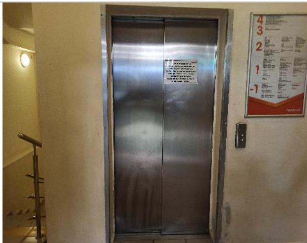
Фото 37. Внутренние помещения 3 этажа.
