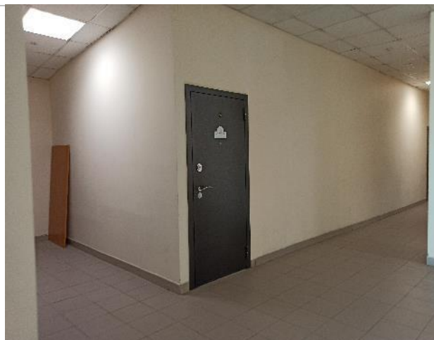
Фото 54. Внутренние помещения 4 этажа.
