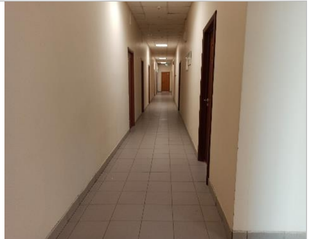
Фото 56. Внутренние помещения 4 этажа.
