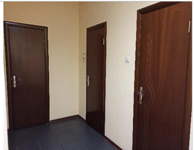
Фото 68. Внутренние помещения 4 этажа.
