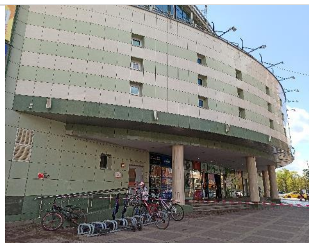
Фото 101. Фасад, входная группа
