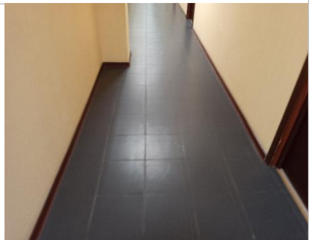
Фото 60. Внутренние помещения 4 этажа.
