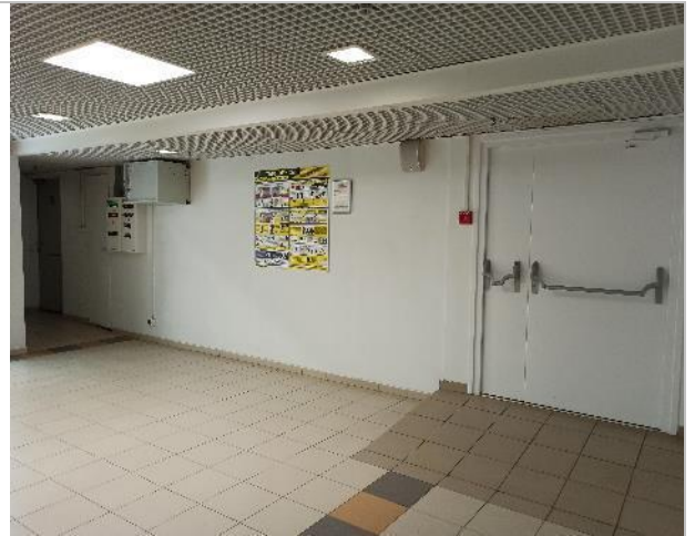
Фото 80. Внутренние помещения цокольного этажа.
