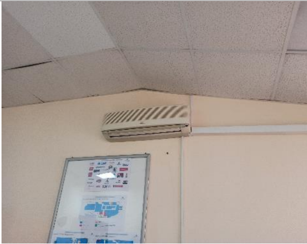
Фото 63. Внутренние помещения 4 этажа.
