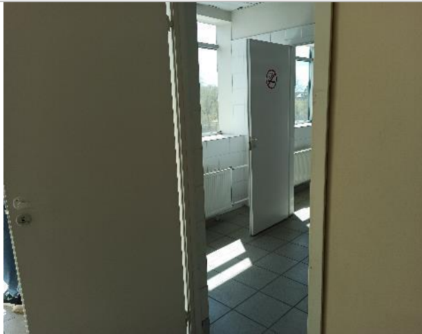
Фото 73. Внутренние помещения 4 этажа.
