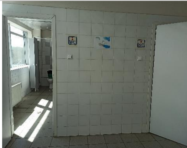
Фото 74. Внутренние помещения 4 этажа.
