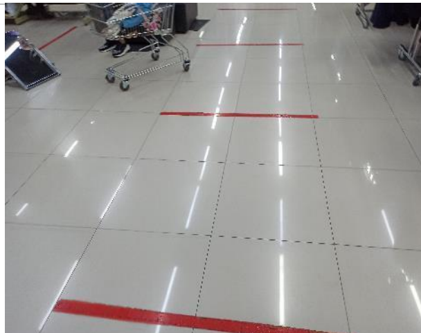
Фото 47. Внутренние помещения 3 этажа.
