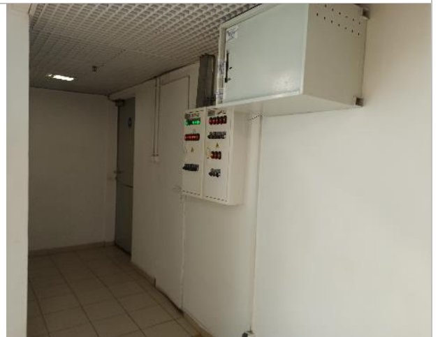
Фото 82. Внутренние помещения цокольного этажа.
