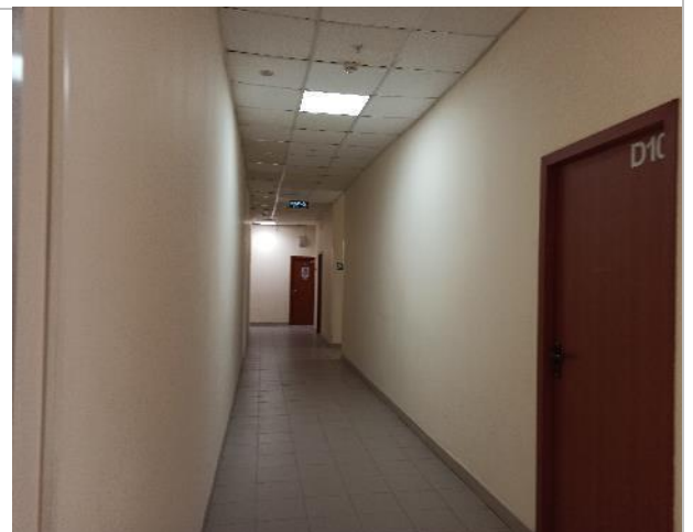
Фото 72. Внутренние помещения 4 этажа.
